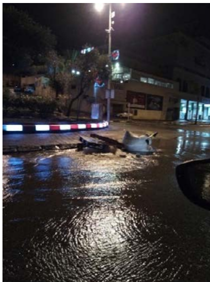
נזקים למערכת הביוב העירונית מחיבור מרזבים לביוב: פיצוץ מכסה הביוב, ינואר 2018. מקור: עיריית שפרעם, 2018.
