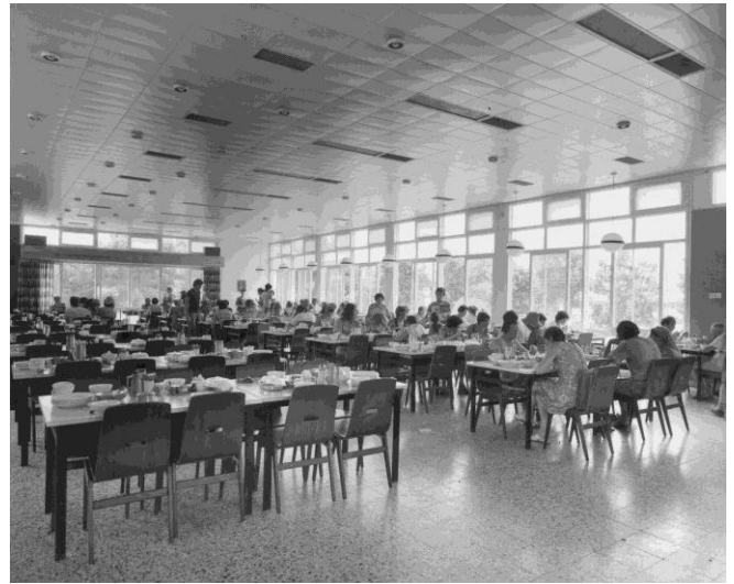
תמונה מספר 18 חדר האוכל בקיבוץ לוחמי הגיטאות. אדריכלית: נעמי יודקובסקי, שנות השבעים. אוסף פרדי כהנא, ארכיון יד טבנקין.
